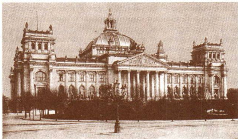
Здание рейхстага в Берлине
