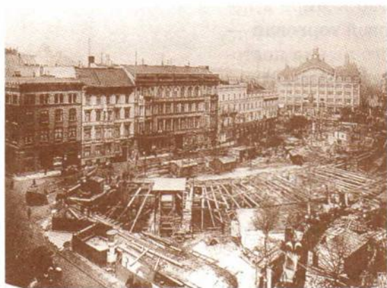
Строительство туннеля метро в Берлине
